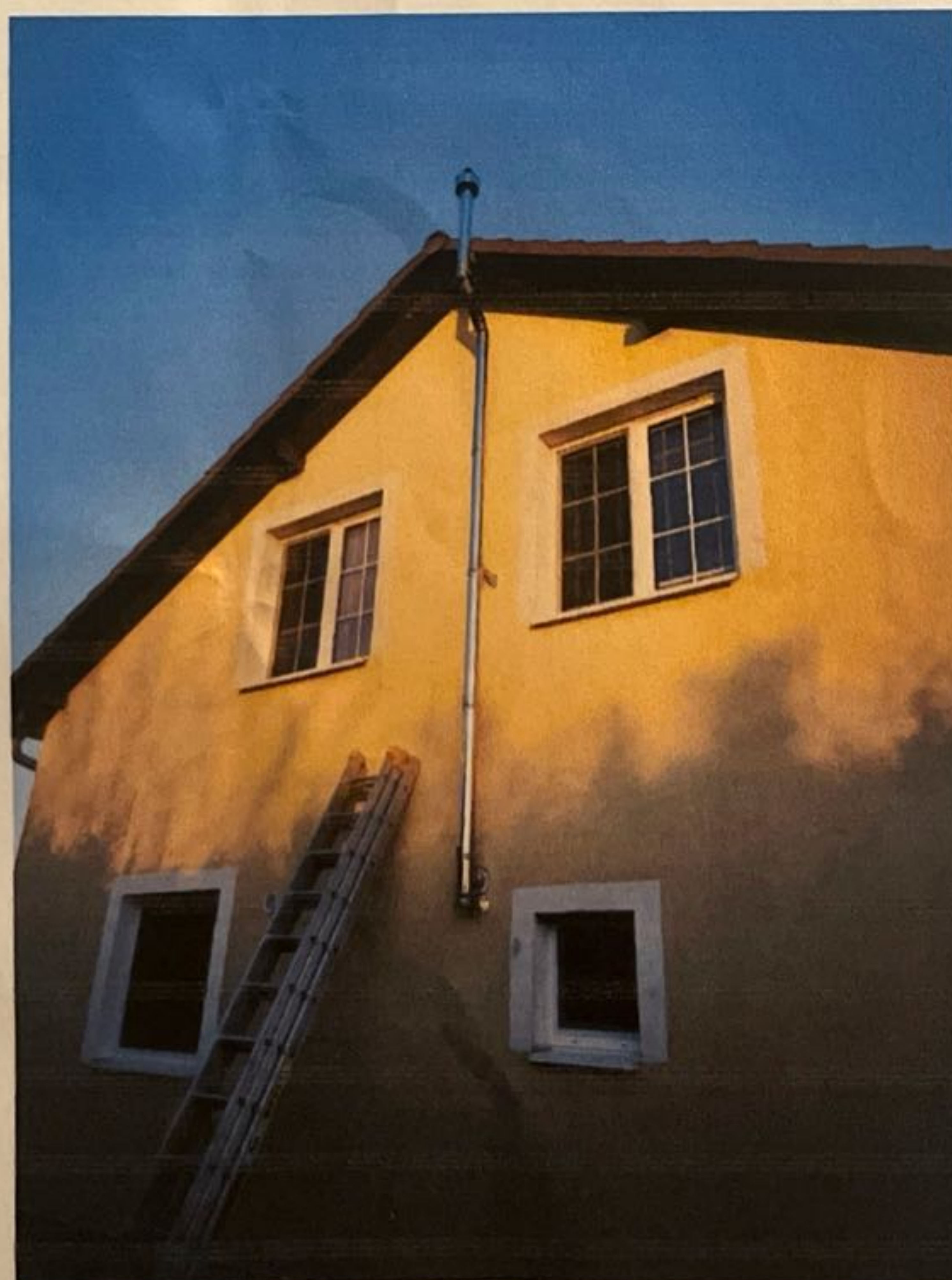
Vyústění do venkovního prostoru
